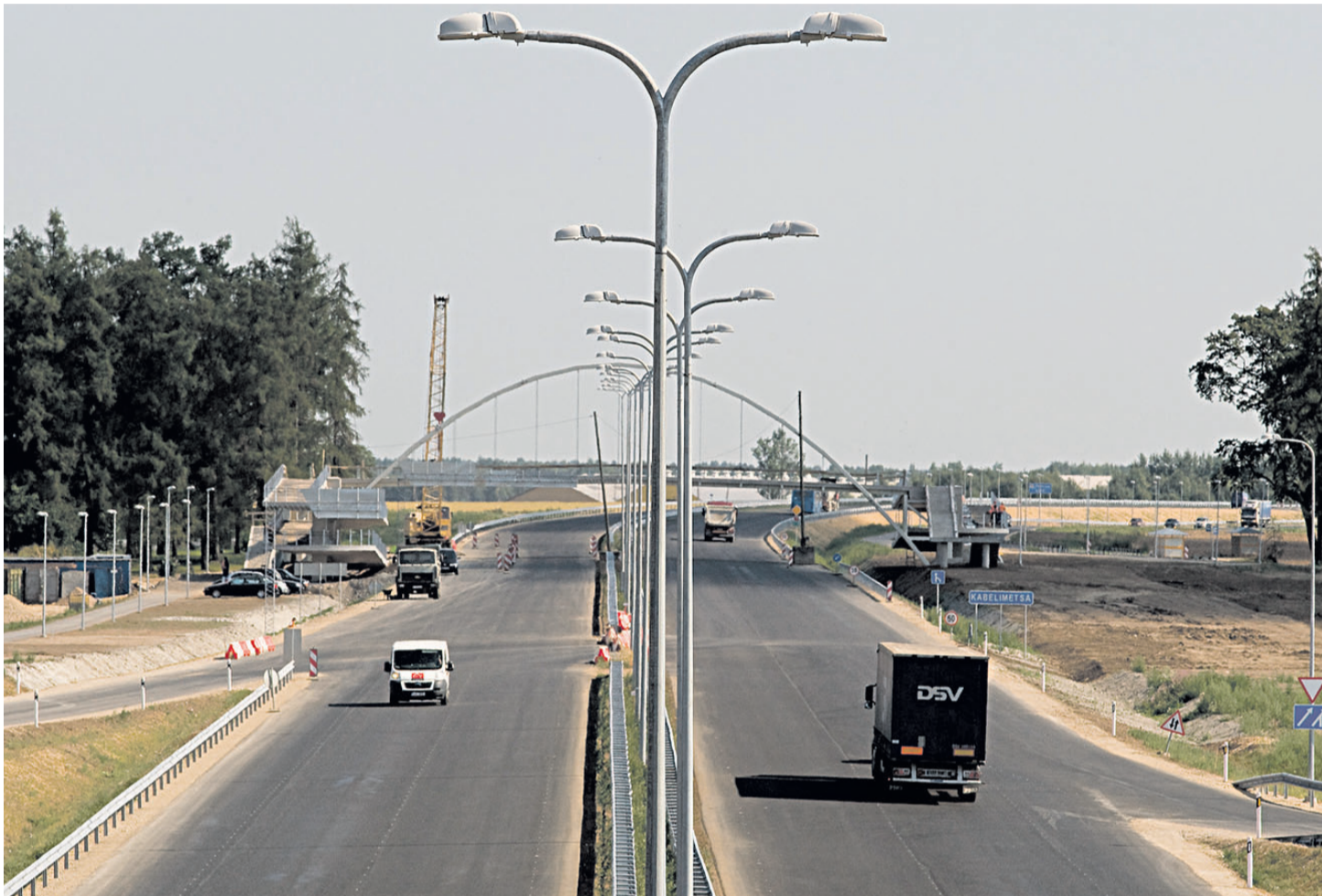
Большая часть нового дорожного отрезка готова. Через неделю у дороги, в основном около перекрестков, высадят тысячи кустов. ЗхМатти КЯМЯРЯ
