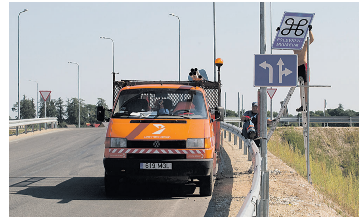
Ведущая сейчас установка дорожных знаков - одна из последних плановых работ.
