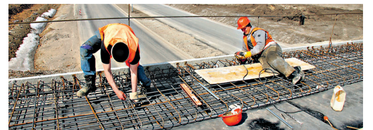
Строится виадук на таммикском перекрестке.
