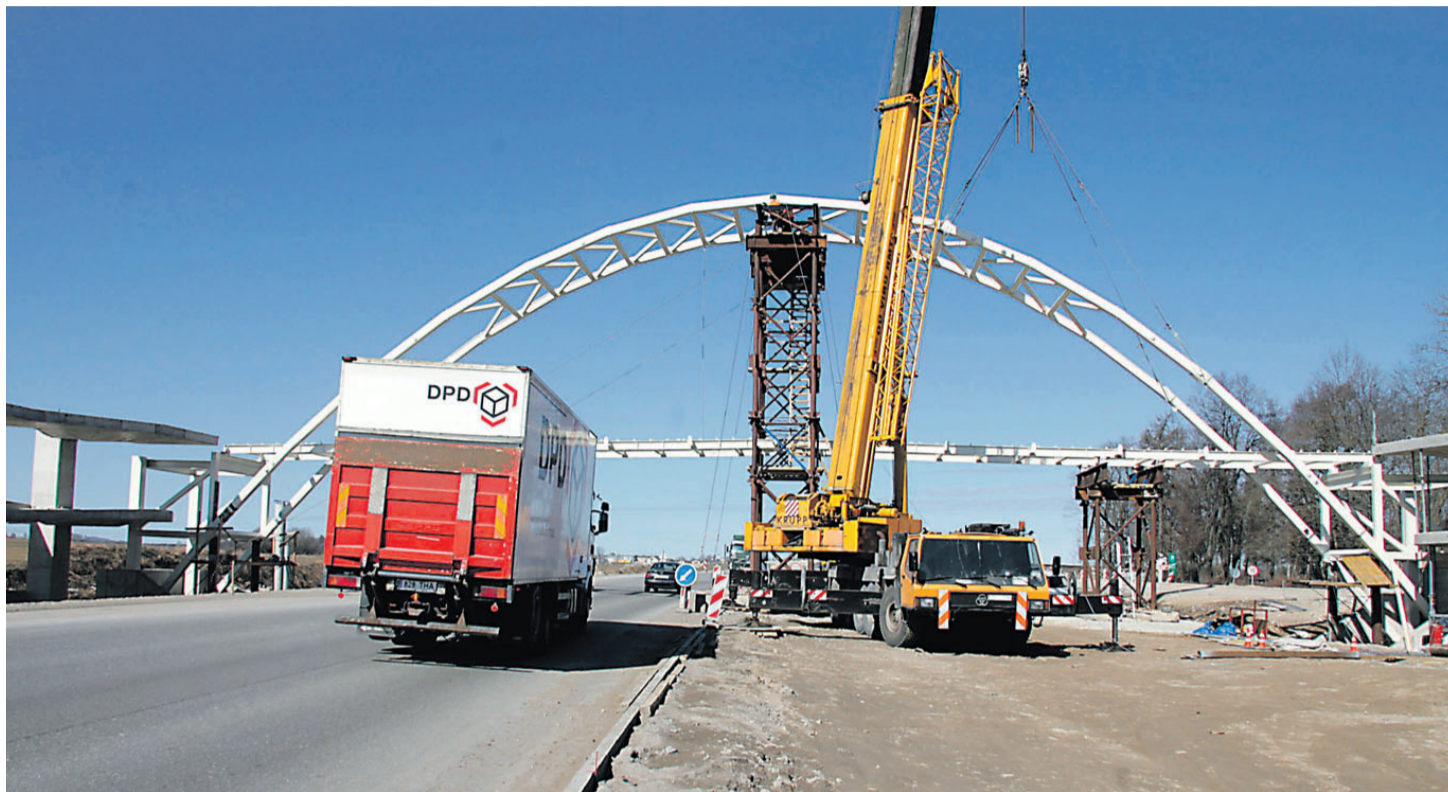
Раскинувшийся над шоссе пешеходный мост достигает в длину почти 50 метров, его стальная конструкция весит около 25 тонн.
