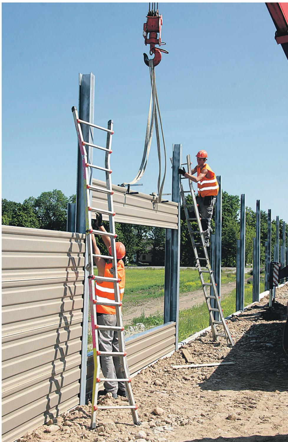
Стеновые панели изготовлены из металла и заполнены шумопоглощающим материалом и препятствующей распространению шума плитой.
