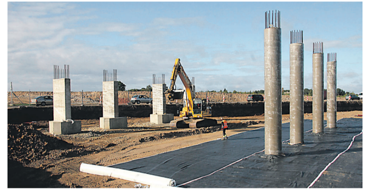
Опоры йыхвиского виадука литые.
