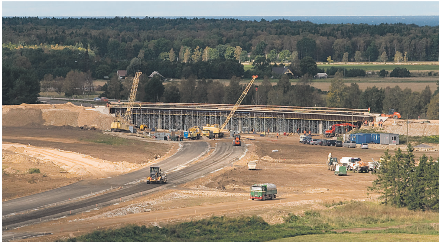
Первым будет готов кукрузеский виадук, где к сегодняшнему дню уже сняты леса и опалубка и идет бетонирование въездных плит и боковых частей.
