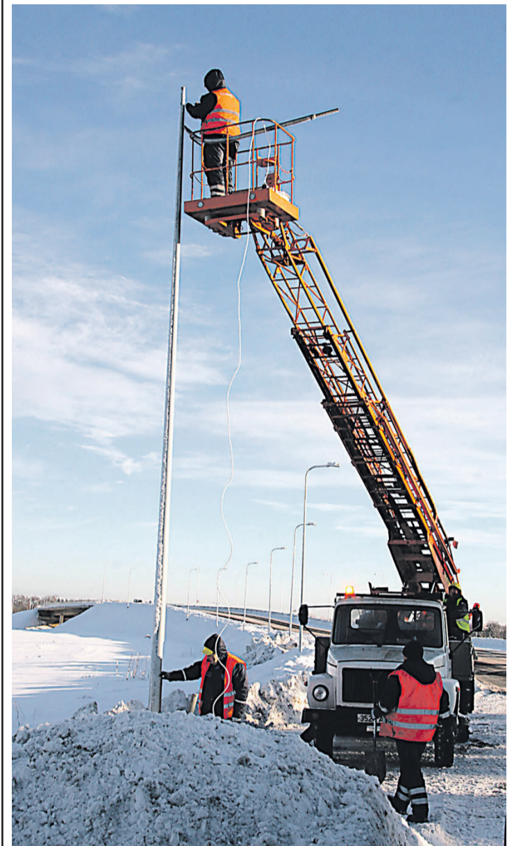
Большая часть столбов и светильников установлена, а электричество поступит туда нынешней осенью.
