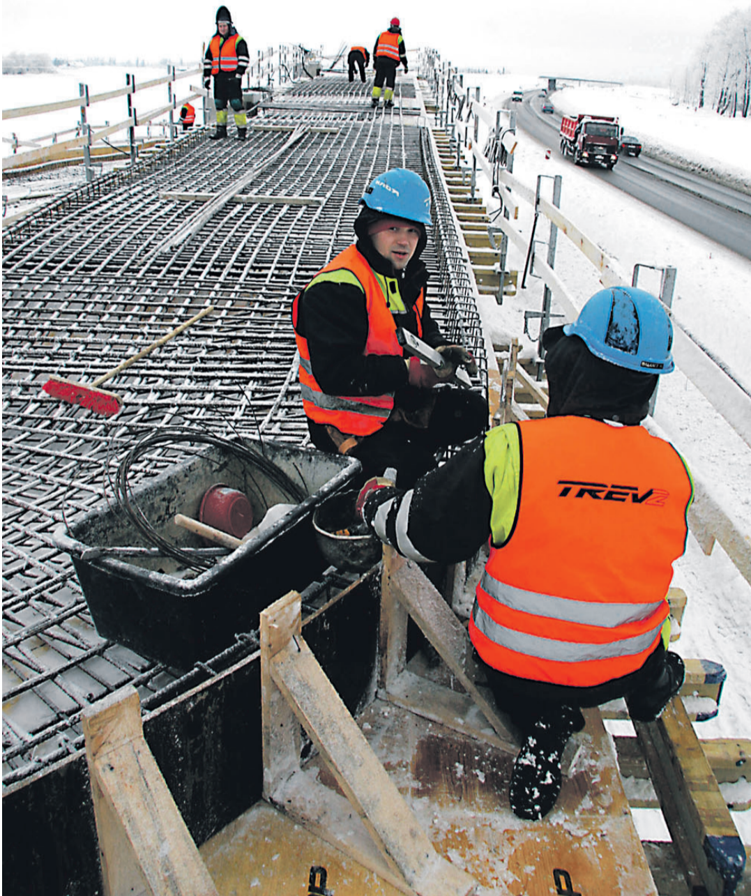
Дорожные работы зимой вести невозможно, но даже в лютые морозы продолжается строительство виадука. На этом снимке запечатлены закаленные морозом строители, возводящие пешеходный мост в районе Эдизе.
